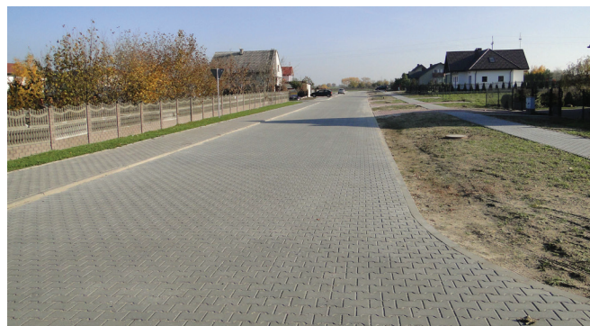
Przebudowa ul. Mazowieckiej w Słubicach
