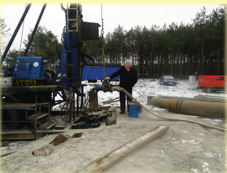
Pompowanie próbne otworów studziennych w Alfonsowie
